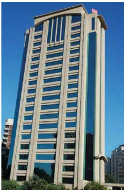
Edifício onde fica o escritório de São Paulo
